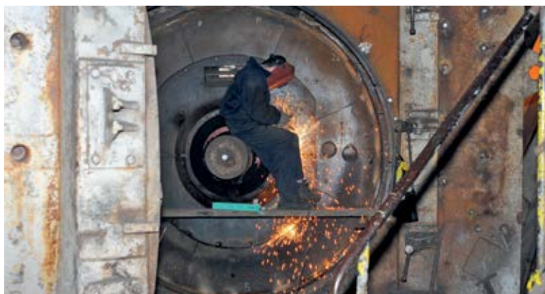
■ Ремонт блока је завршен средином јуна
