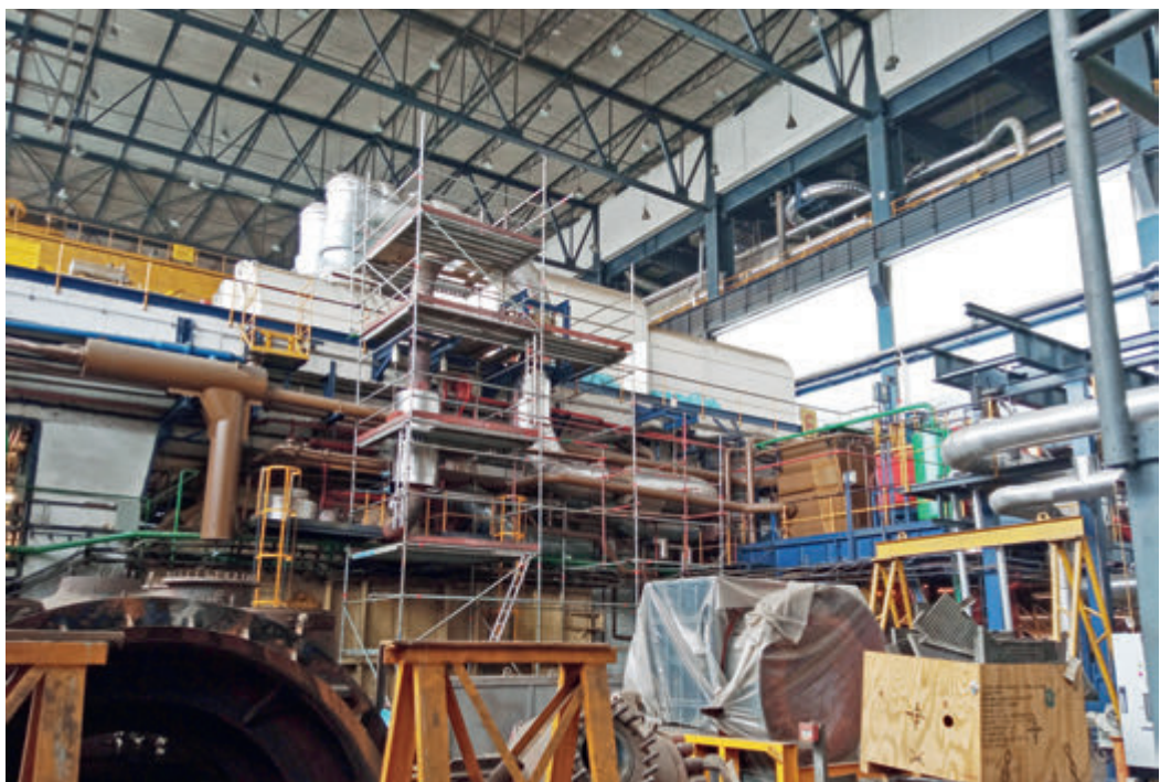
■ Блок А6 међу прима у ремонту
