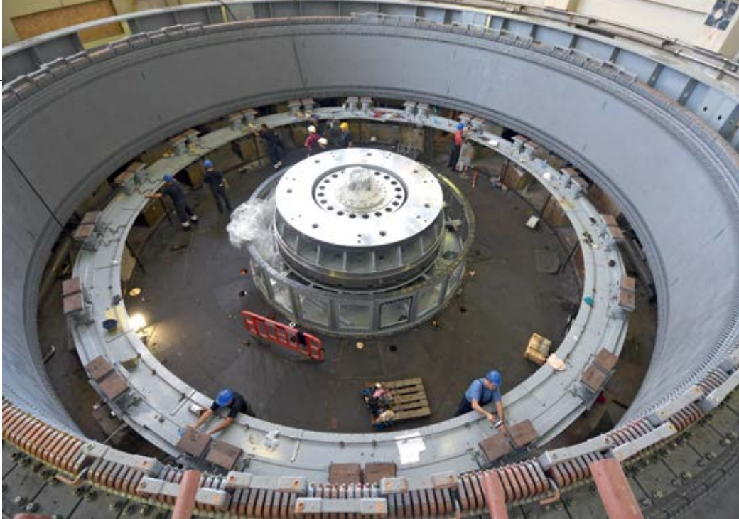
■ Статор главног генератора је завршен
