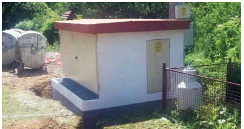
■ Управо завршена изградња ТС напонског нивоа 10/0,4 kV
