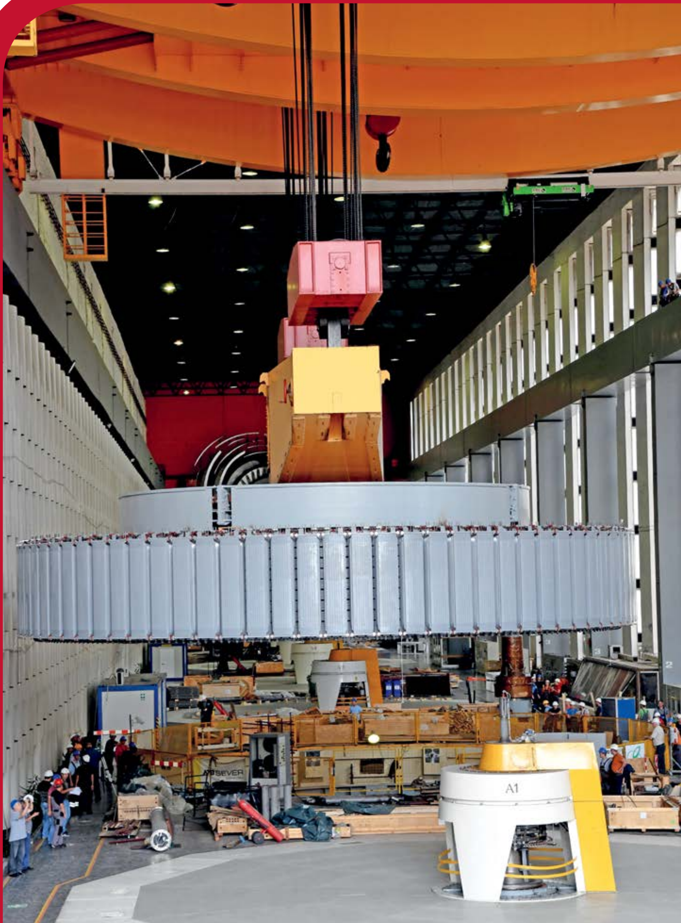
■ ХЕ „Ђердап 1“, пренос ротора главног генератора А2. Тежина терета је 610 тона, а носе га две упарене дизалице.
