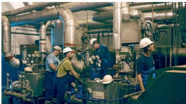
■ Монтажа сигурносних вентила
