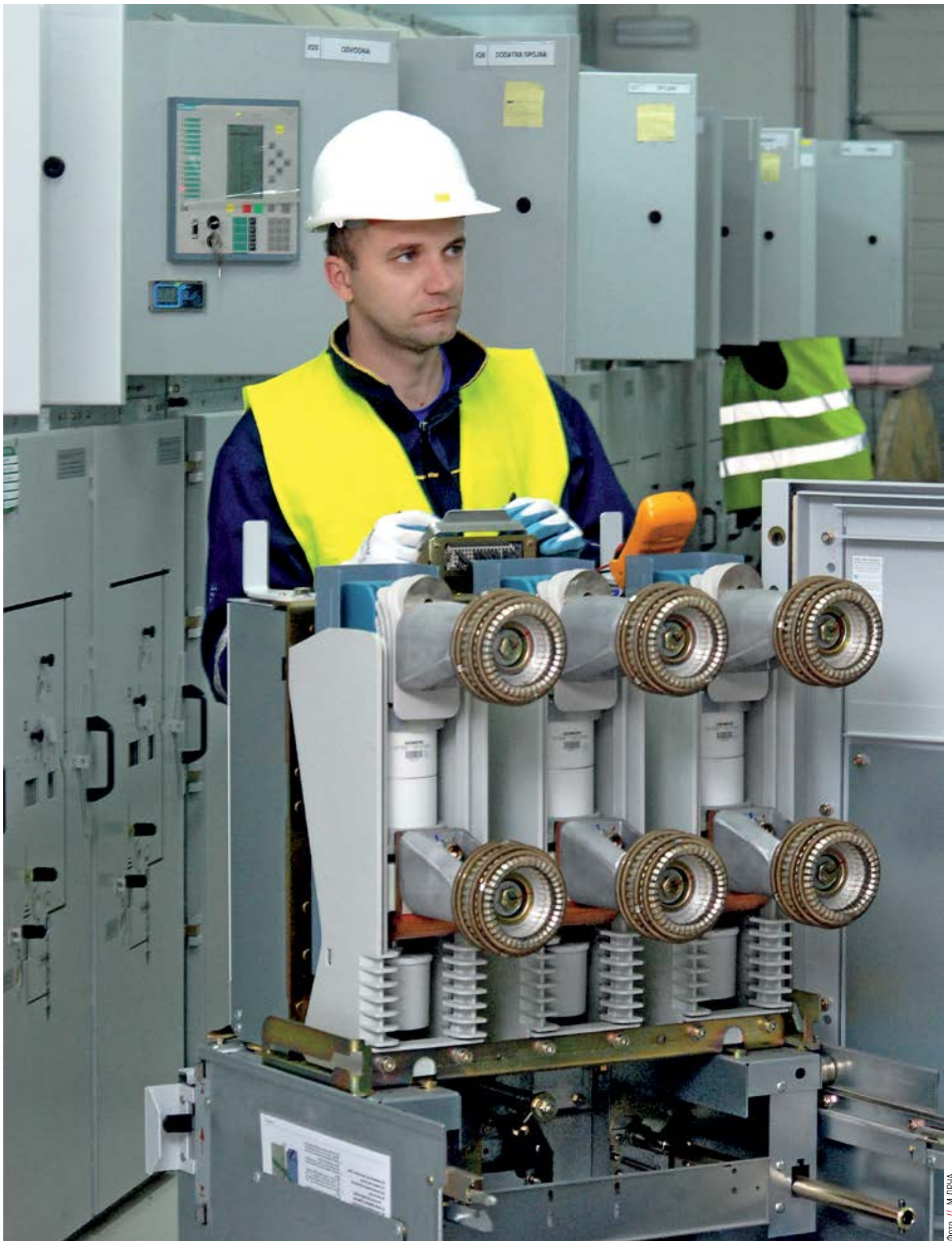
Монтажа 10 kV прекидача у ТС 110 Нови Београд
