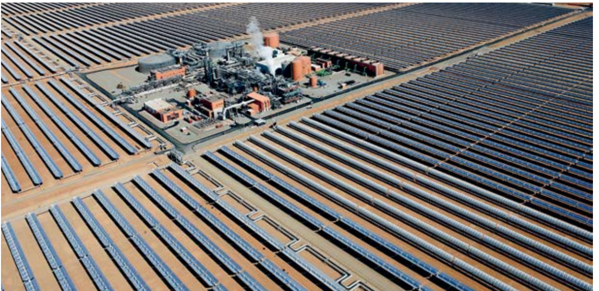
■ Комплекс Нур - највећа инсталација за добијање електричне енергије од сунца над Сахаром
