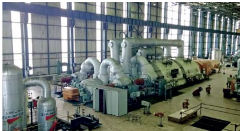
■ Други део ремонта блока ТЕНТ Б1 обављен је у септембру
