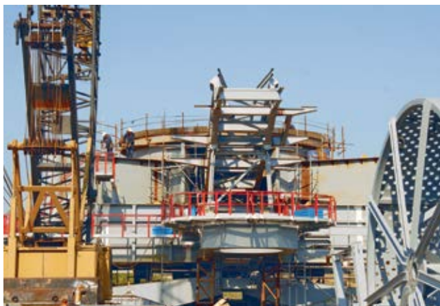
■ Радови на монтажном плацу
