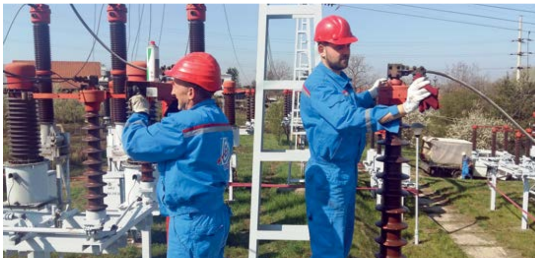
■ Ремонтни су стартовали радовима у ТС „Београд 10“ у Мислођину
