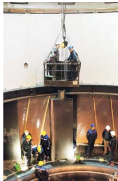
■ Монтажа прве од укупно осам лопатица
