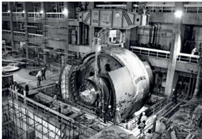
■ Монтажа блок-генератора, фото: Милорад Дрча
