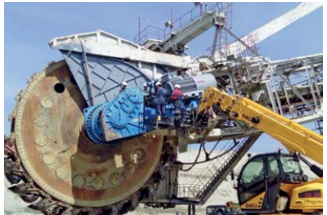
■ Радови на редуктору радног точка багера SRs 1300
