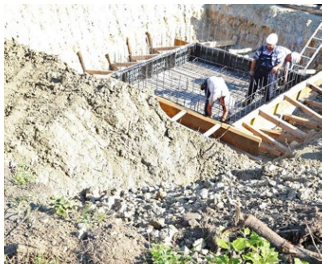
■ Бетонски радови на постројењу C2
