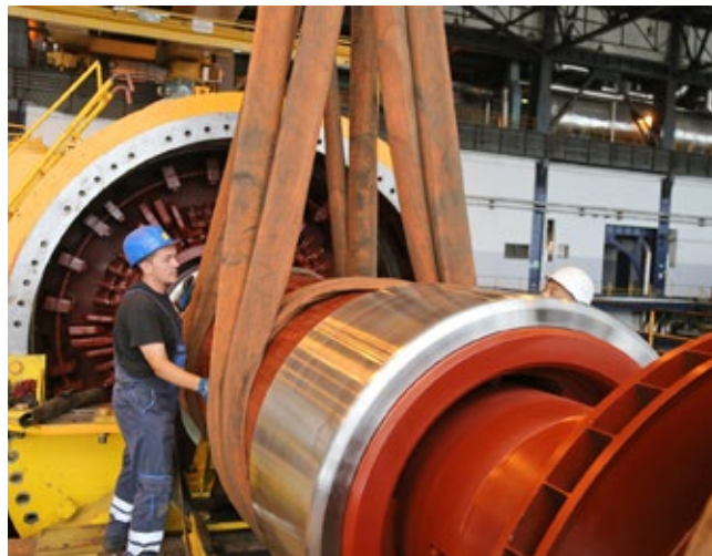
■ Враћање ротора генератора
