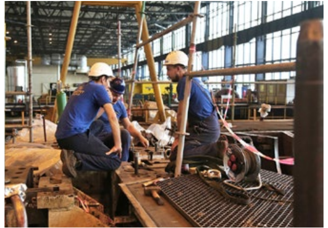
■ Радови на турбоагрегату
