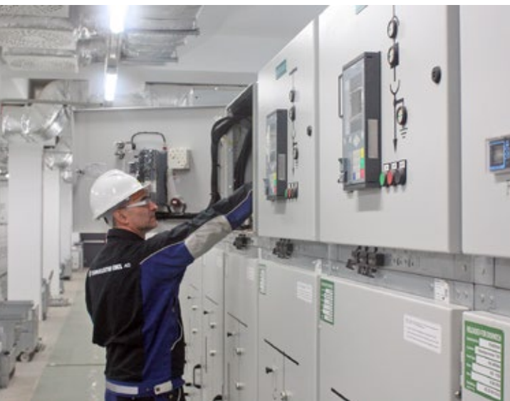
■ Електрорадови у електрокомандној згради фазе I
