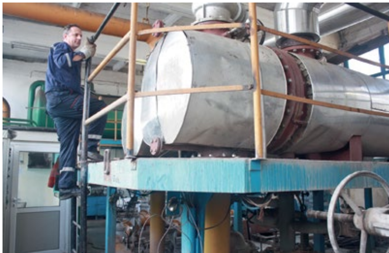
■ Провера стања резервоара
