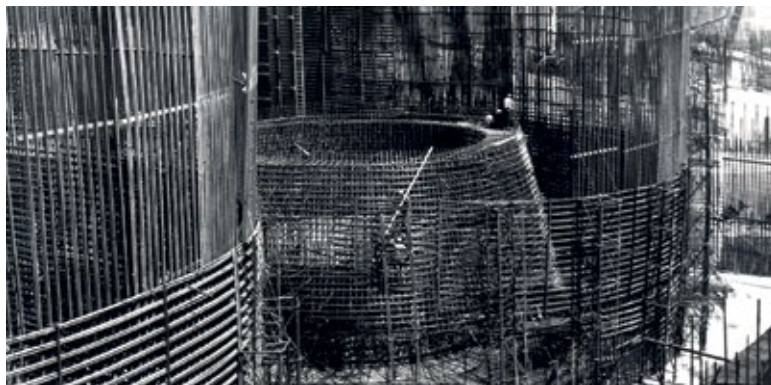
■ Припрема за бетонирање сифона
