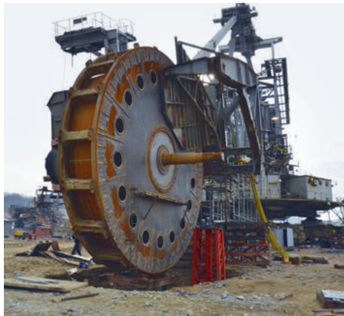
■ Ремонт багера SRs 2000
