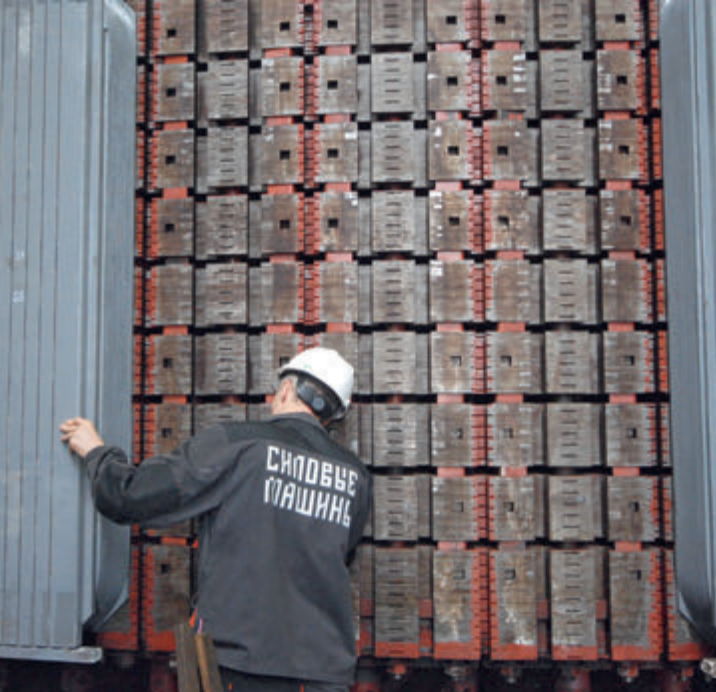
■ Монтажа полова ротора главног генератора
