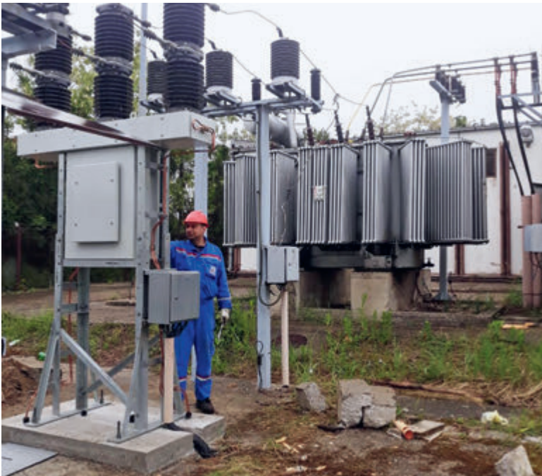
■ Први пут је извршена замена 35 kV вакуумских прекидача за спољашњу монтажу
