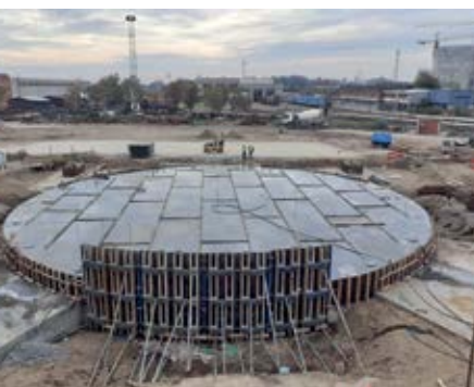
■ Апсорбер за блокове 5 и 6 - демонтажа оплате темељне плоче
