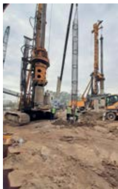
■ Апсорбер за блокове 3 и 4 - бушење и бетонирање шипова
