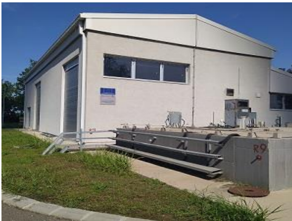
Слика 2 Постројење за пречишћавање отпадних вода ТЕКО Б
