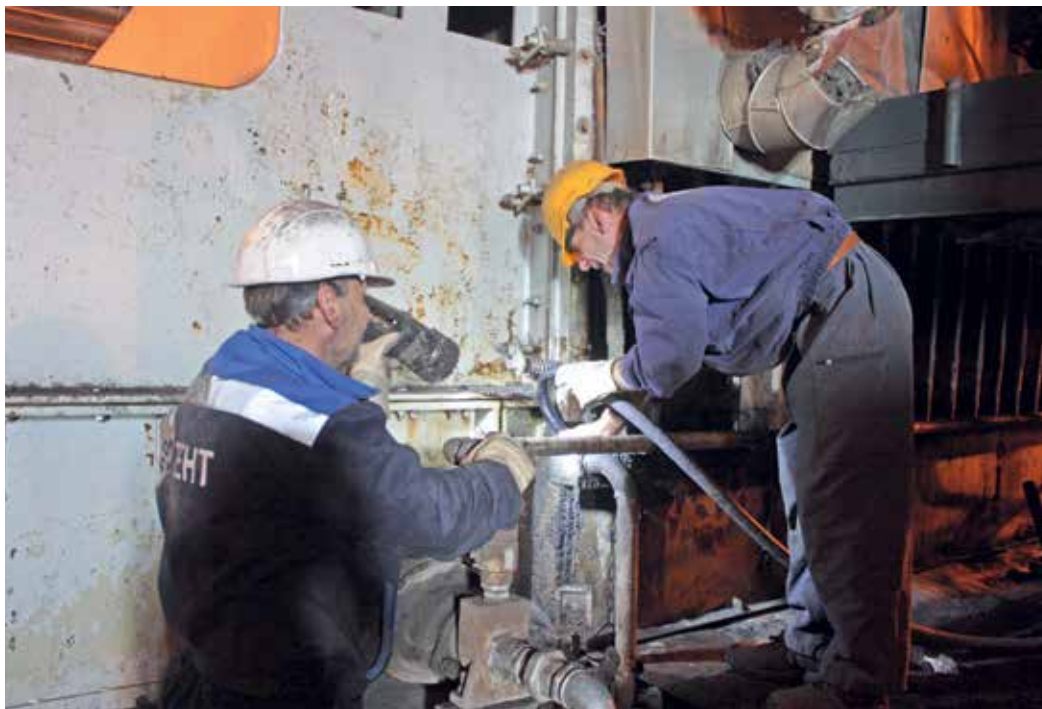
Ремонтни радови на једном од блокова ТЕНТ Б
