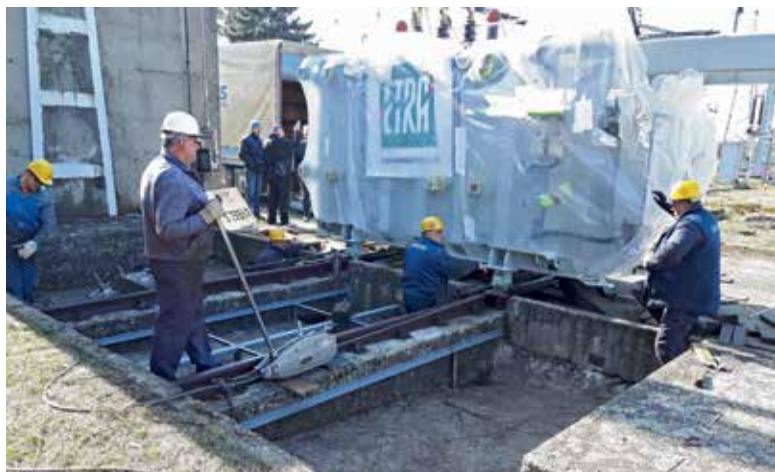
■ Уграђује се други трансформатор па ће инсталисана снага ТС ускоро бити дуплирана
