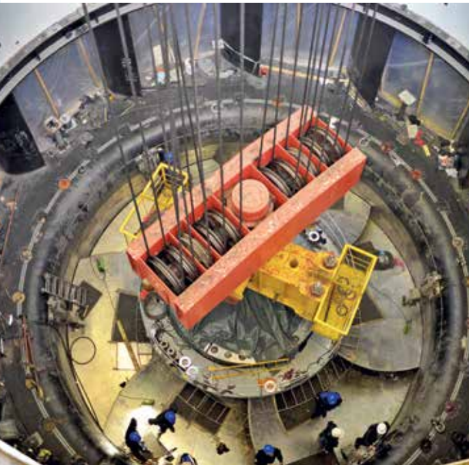
■ Монтирано радно коло турбине
