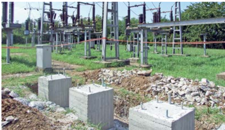
■ TC Лапово - нове бетонске стопе
