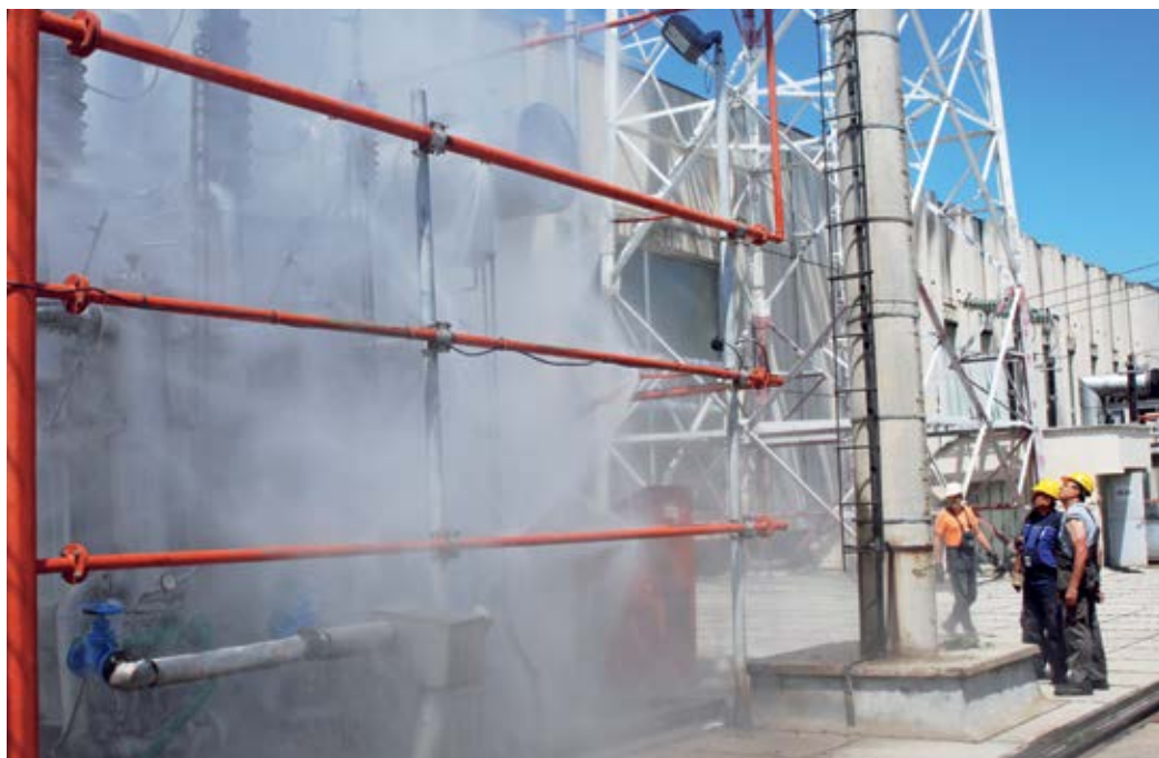
■ Ремонт трансформатора завршава се провером система за гашење пожара
