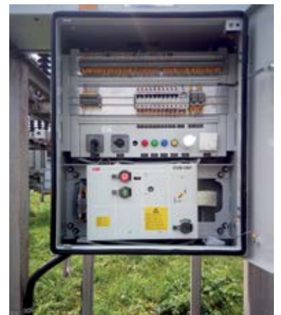
■ Замена 35 kV прекидача у ТС „Алексинач 2“
