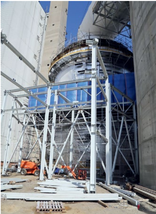
■ Конструкција носача димоводних канала
