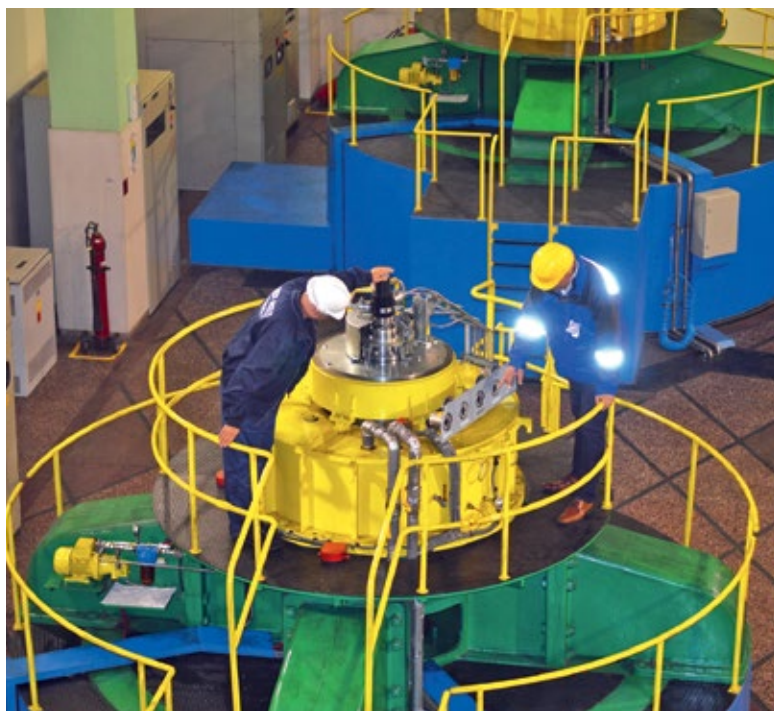
■ Завршена ревитализација сва три агрегата у ХЕ „Међувршје“
