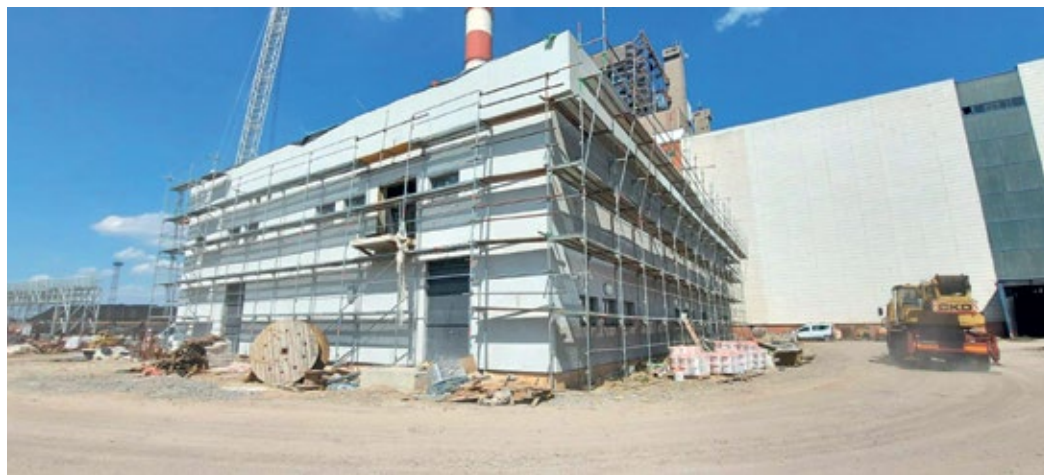
■ Електро-командна зграда - израда фасаде
