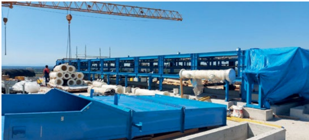
Силос гипса - монтажа машинске опреме
