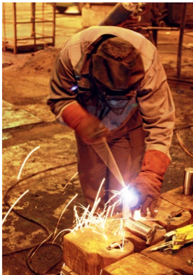
■ Ремонтни радови на блоку А2
