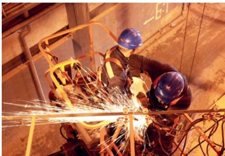
■ Поправка клизне траке са кабловима
