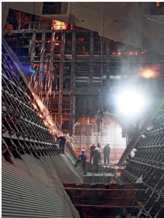
■ Сечење цевног система котла блока Б1
