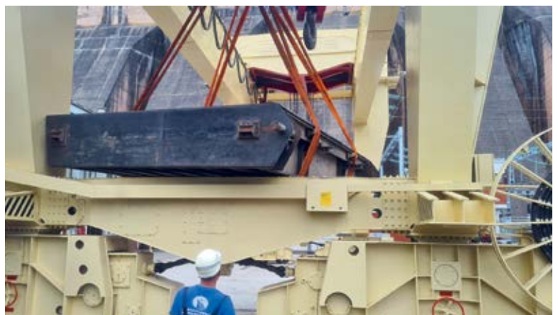
■ Транспорт сифонског затварача на монтажни простор
