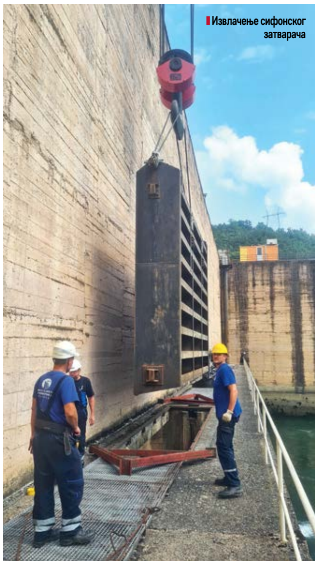
■ Транспорт сифонског затварача на монтажни простор
