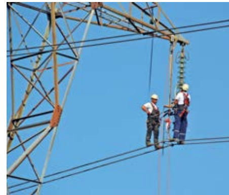
■ Демонтажа проводника са 400 kV далековода
