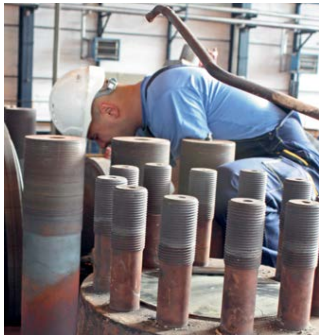
■ Ремонт блока А1
