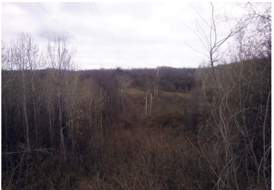
■ Реконструкција дистрибутивног вода 10 kV „Врх Букуље“
