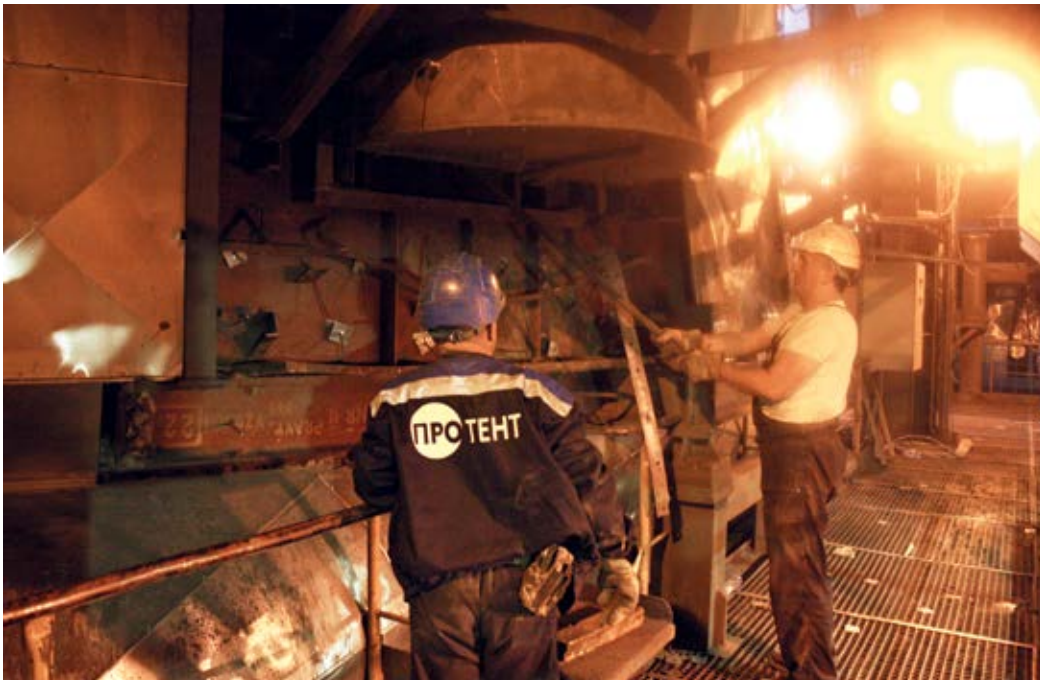
■ Ремонт блока А6
