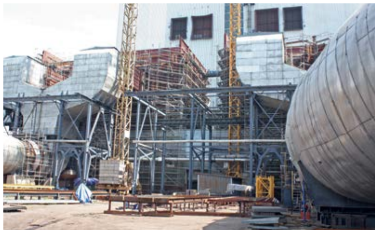
■ Ревитализација електрофилтера 2012. године
