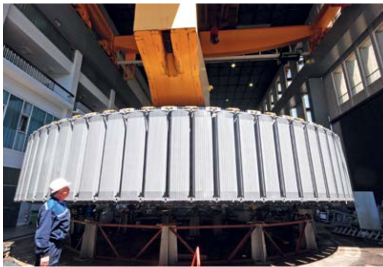
■ За пренос ротора главног генератора неопходна је геодетска асистенција
