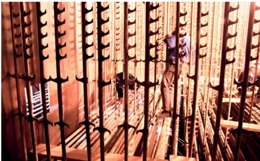
■ Радови на цевном систему котла у првој фази ревитализације
