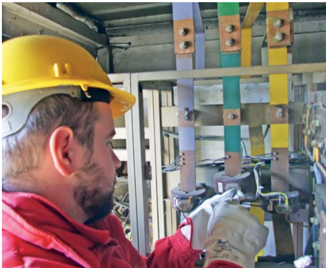
■ Инсталација контролног бројила у ТС
