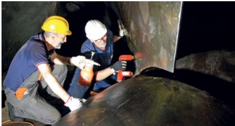
■ Контрола лопатица радног кола
