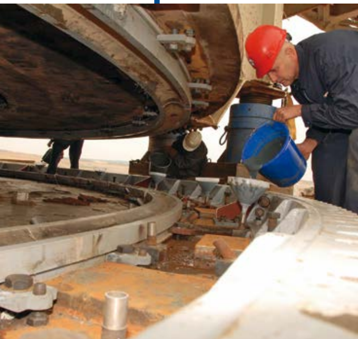
Ремонти на копу „Дрмно“
