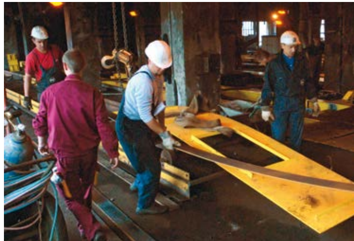
Један од главних, тренутно актуелних, инвестиционих радова – реконструкција електрофилтерског постројења
