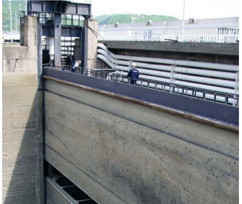
■ Током ремонта превођење бродова обављаће румунска преводница
