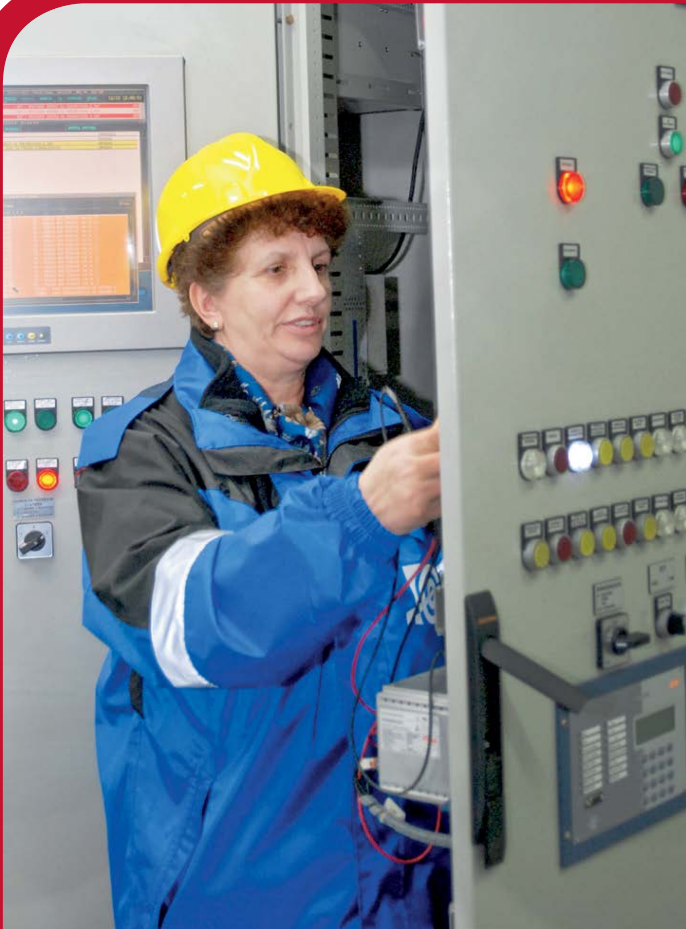
■ Електротехничар у ХЕ „Ђердап 2“, Љубица Истодоровић проверава услов за побуду по напону генератора у оквиру последње припреме пред синхронизацију агрегата број 6 на мрежу.
