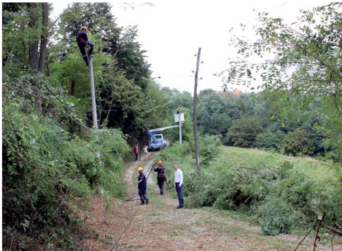
■ Реконструкција нисконапонске мреже
