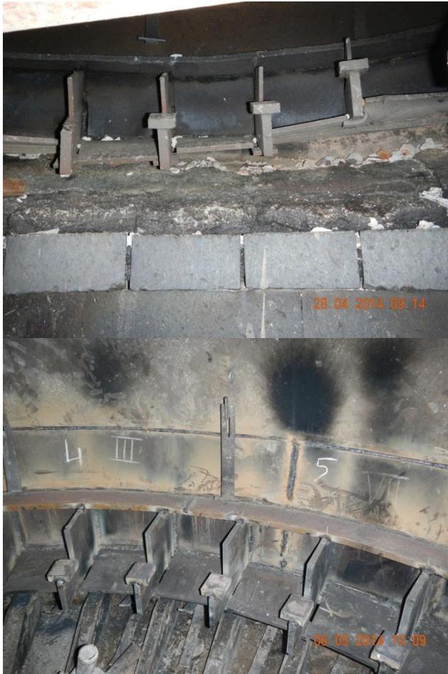
Слика 1: Прстен реци канала 46 пре санације
