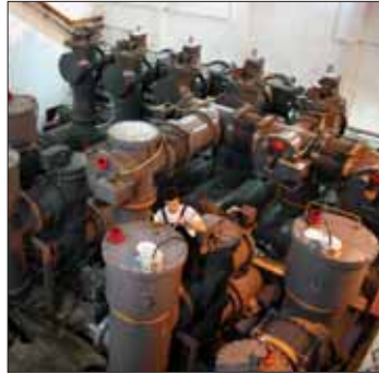
Трансформаторска станица и разводно постројене „Београд 36“ познатије као ТС „Обилић“ стартује у октобру
