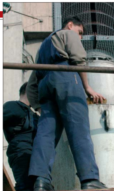
На другом агрегату санираће се оштећења на турбини и генератору
