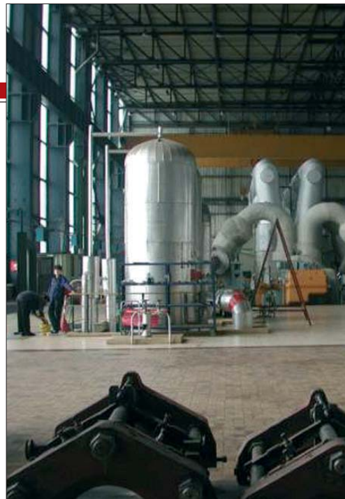
У ремонту блока А 2 велики захвати на котловском систему
