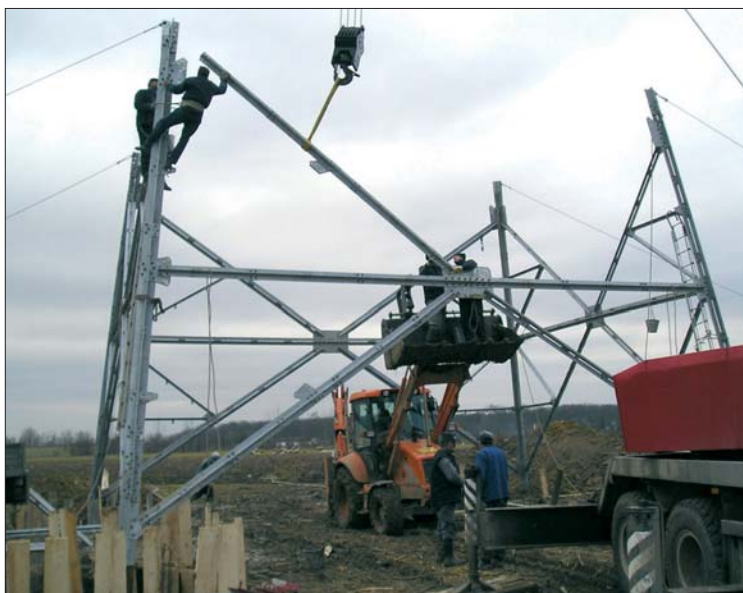
Монтажа сегмента за специјални прелазни стуб
