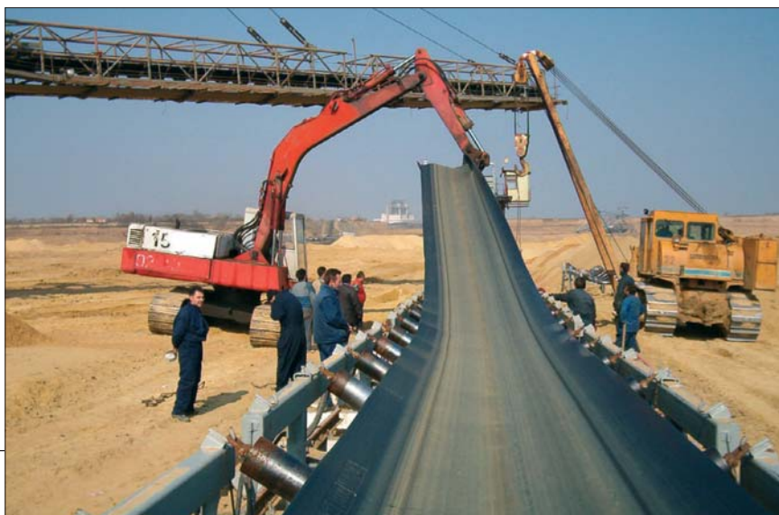
Уместо садашње од 1,4 метра, нова транспортна трака за отпрему угља са "Дрмна" биће шири за четиристо милиметара
