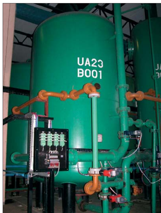
Линија за производњу деми воде са капацитетом од 100 метара кубних на час, подмирује потребе блокова
