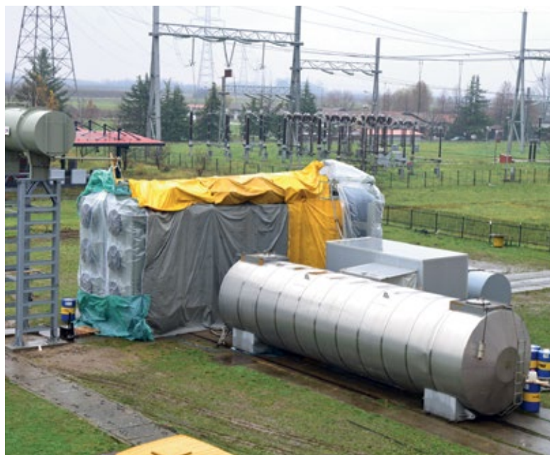
У ТЕНТ Б допремљен нови блок трансформатор
