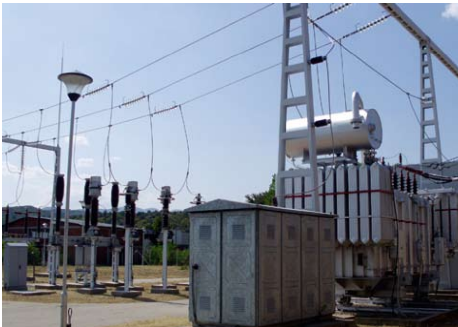
Енергетска појачања југа Србије: ТС „Врање 2“
