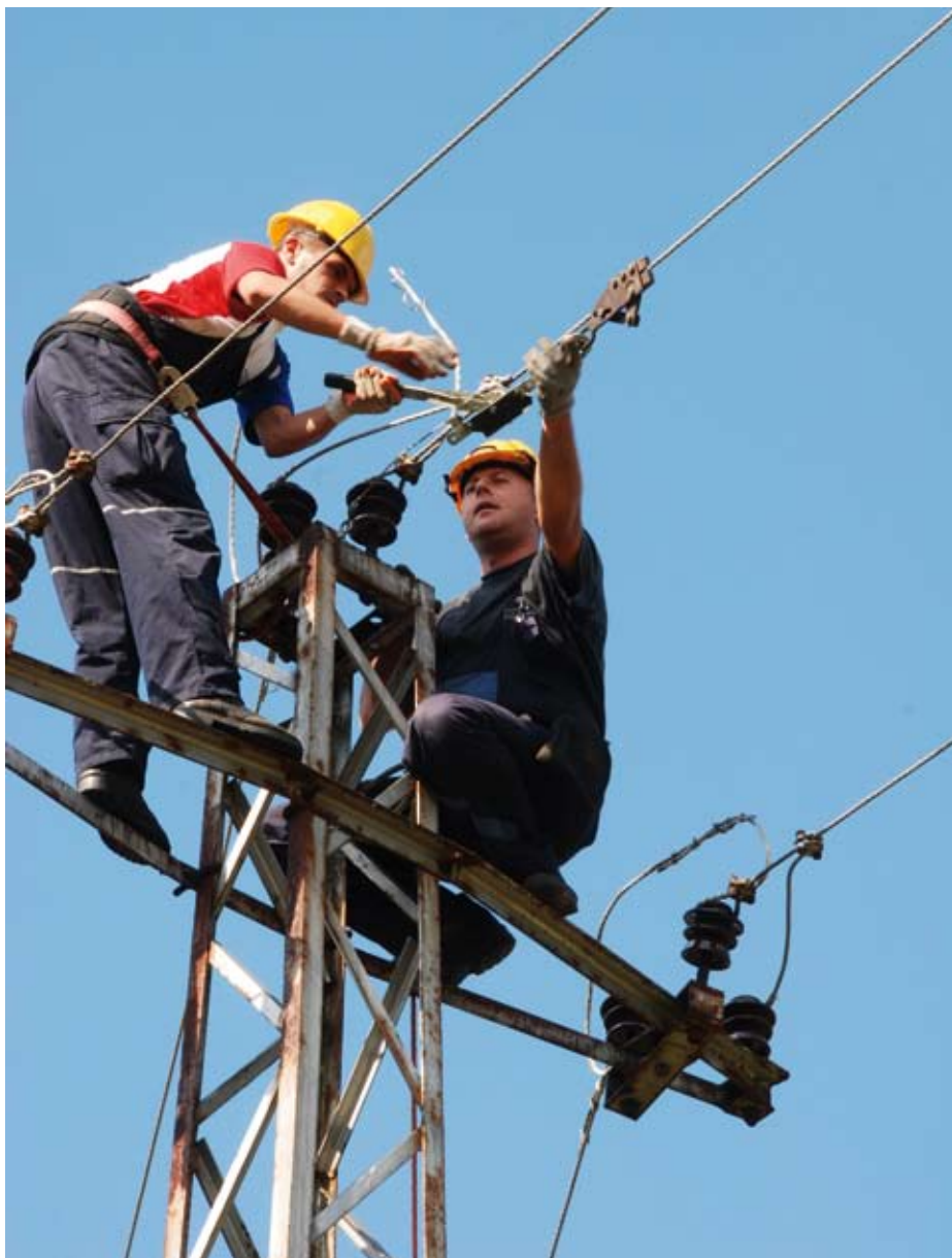
Замена изолатора на 10 kV далеководу
