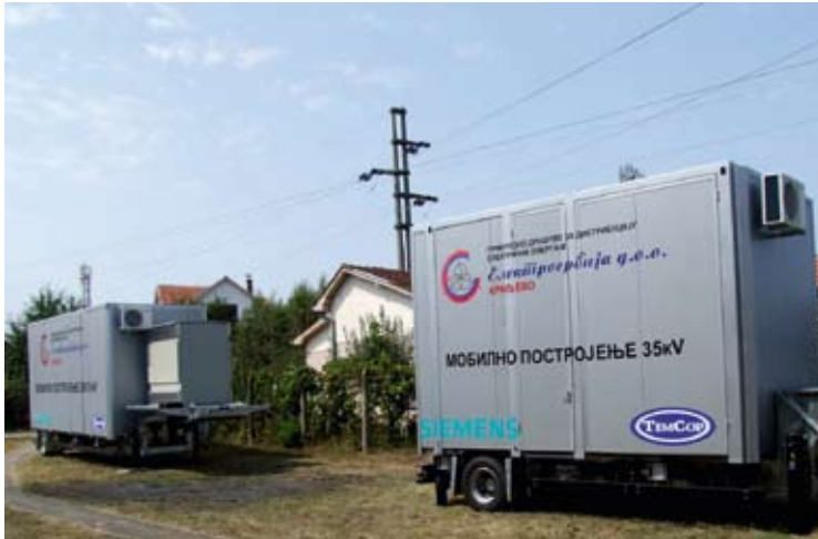
Мобилна ТС може да функционише као целина и самостално по напонским нивоима
