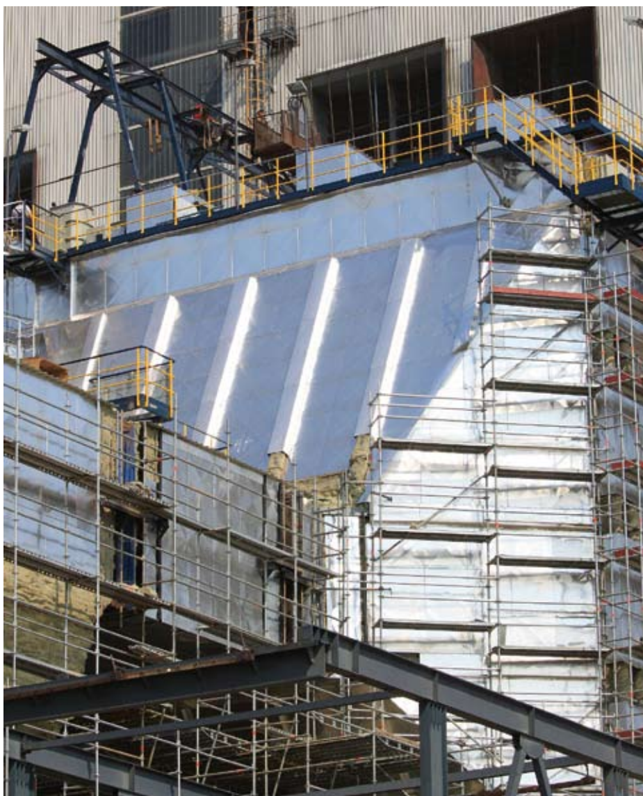
Највећи део реконструкције електрофилтера финансиран из донација ЕУ
