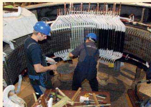
У току су радови на статору агрегата
