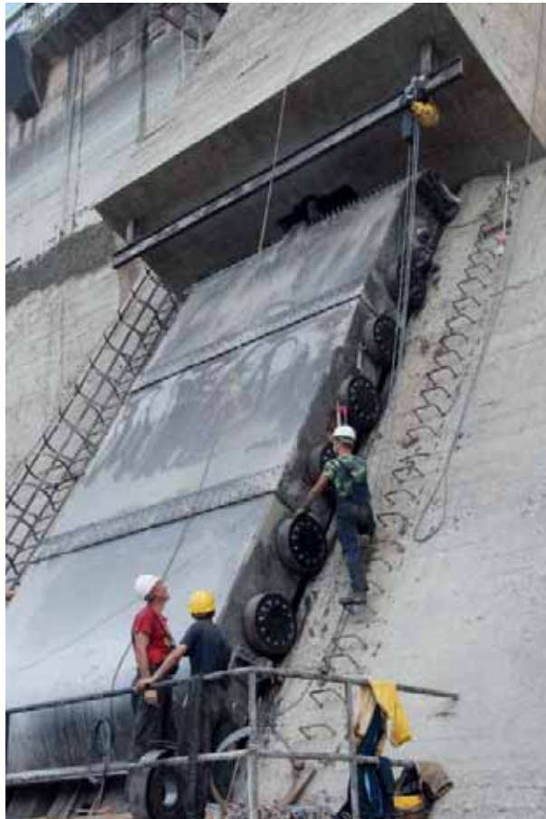
У сва четири агрегата ХЕ „Бајина Башта“ завршена санација на табластим затварачима
