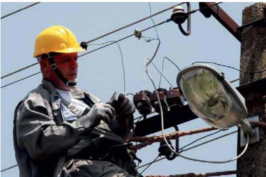
Стандардима квалитета подлеже и изградња објеката: ПД „Електровојводина“
