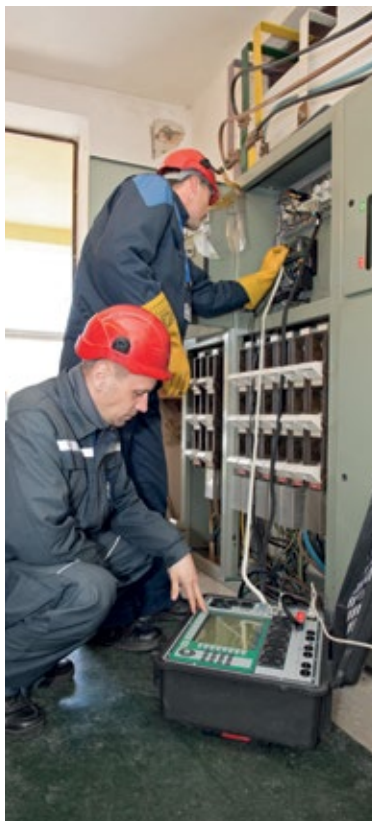
■ Контрола исправности бројила
