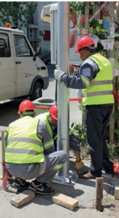
■ Замена стубова у Улици Маријане Грегоран
