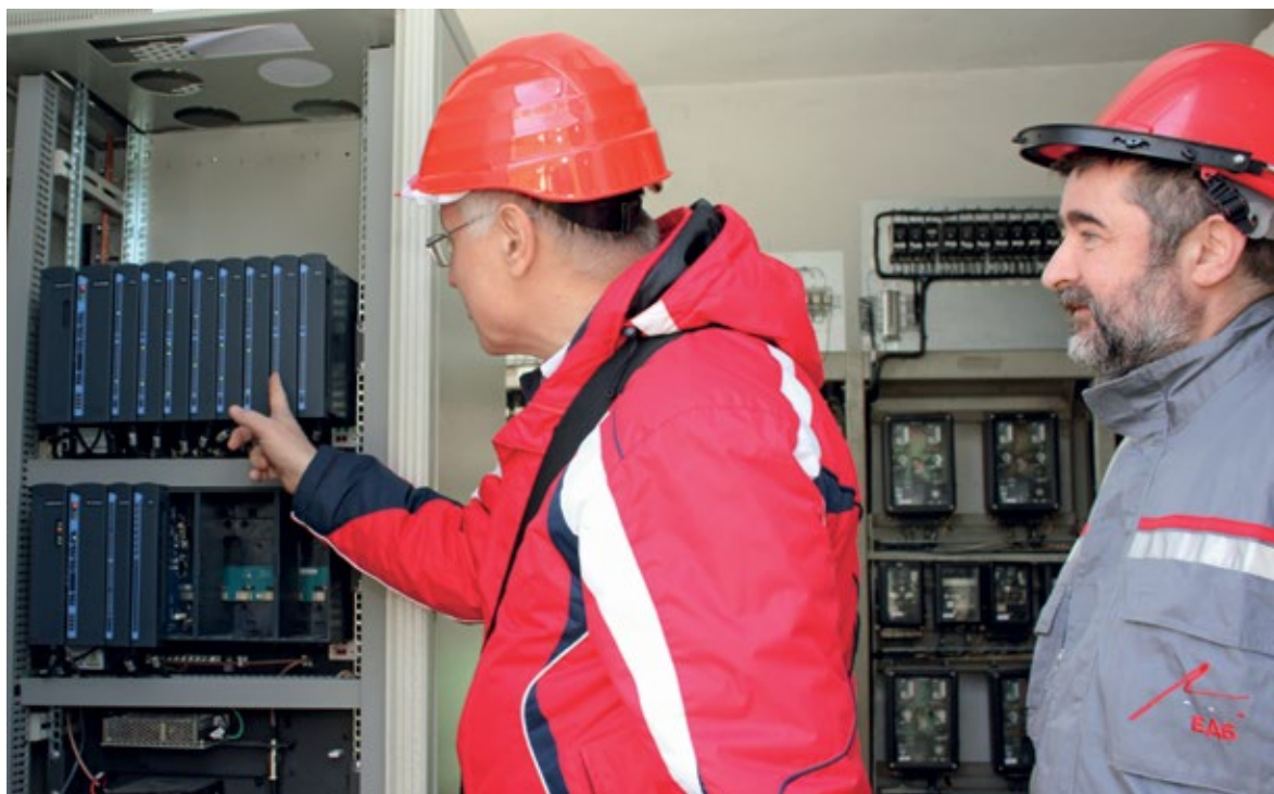
■ Повезивањем у систем даљинског управљања старе ТС доведене су на ниво модерних електроенергетских објеката
