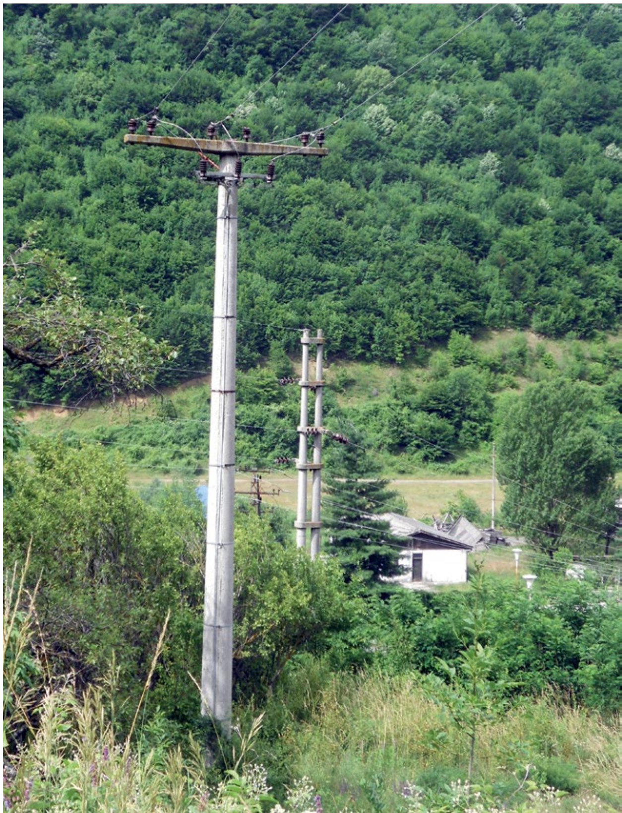
■ Изградњом овог далековода и уградњом модерне опреме омогућено стабилније и поузданије снабдевање електричном енергијом
