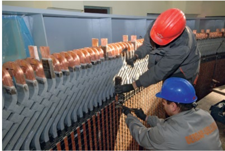
■ Радови на статору генератора
