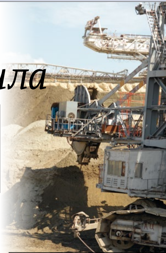
Прве ремонтне активности на ПК „Дрмно“ требало би да почну већ половином априла
