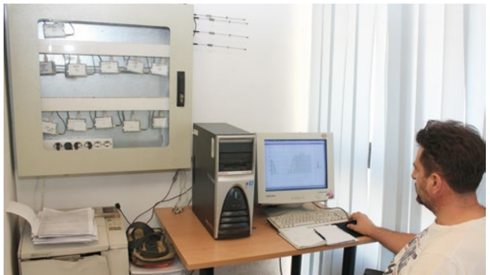
Путем станичног рачунара Служба мерних група даљински читава потрошњу и контролише исправност мерних уређаја, што је од великог значаја за смањивање губитака
