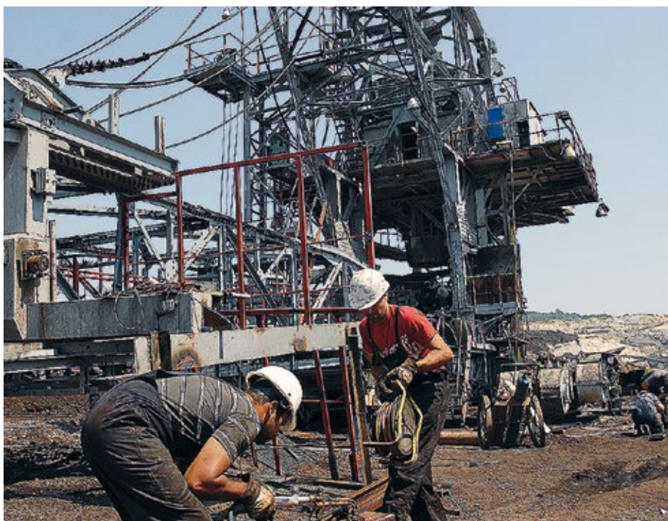
Нереализоване јавне набавке отежале ремонте: са ПК „Поље Б“
