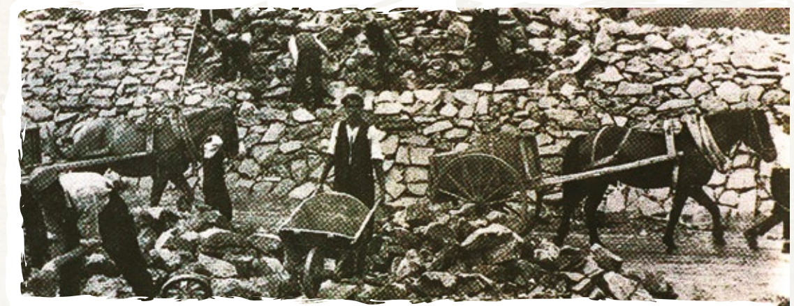
Прва земљана брана изграђена је на Власинском језеру 1948. године
