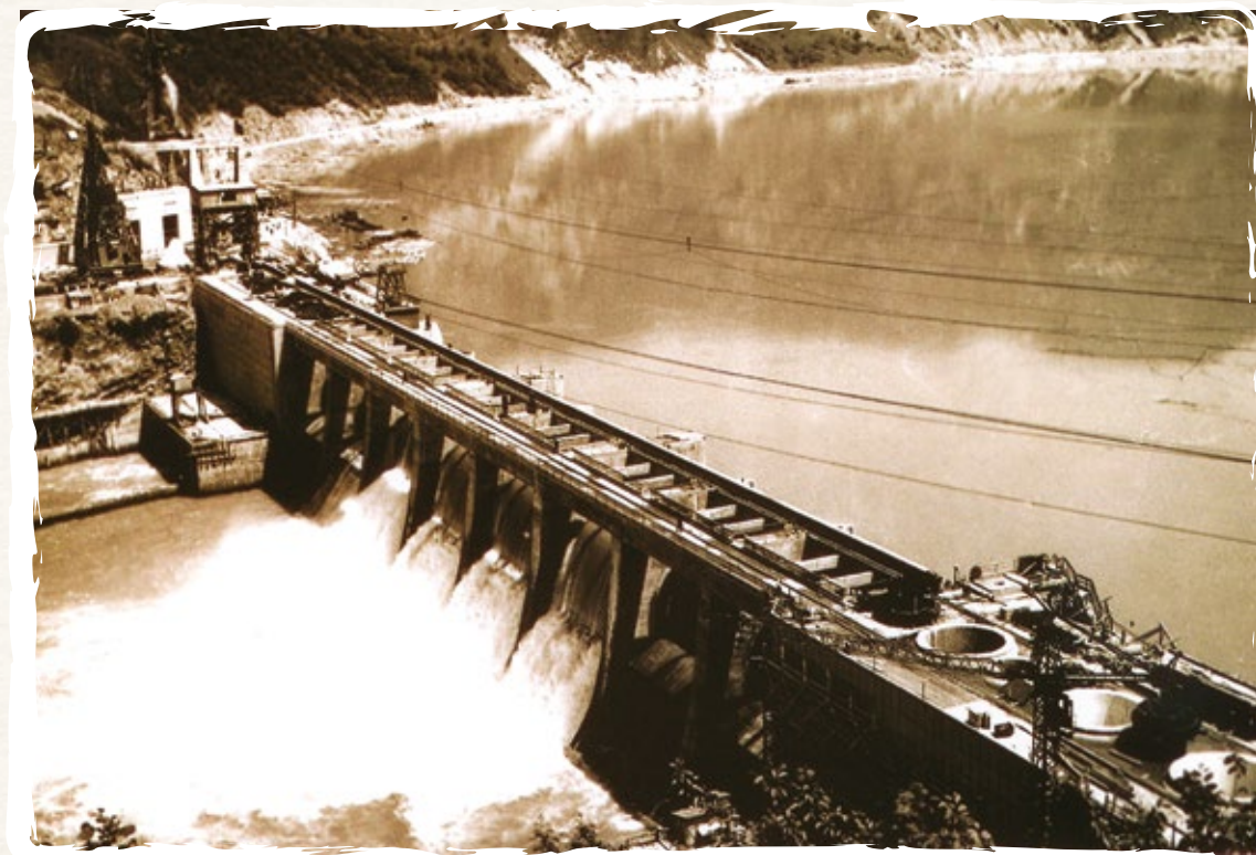
Радови на изградњи ХЕ „Зворник“ Електрана је почела да ради 1955. године
