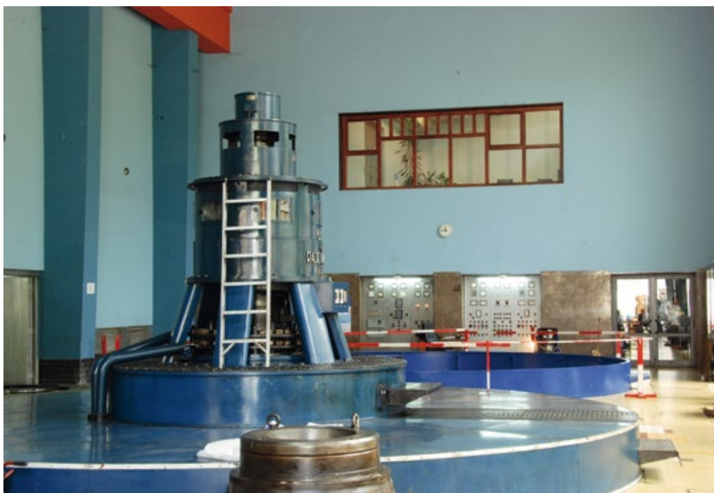
Ремонти у ХЕ „Бистрица“ и ХЕ „Кокин Брод“ једини су пролећни ремонти
