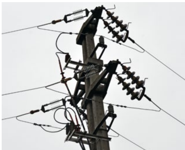
Композитни изолатори су и до три пута јефтинији од одговарајућих порцеланских
