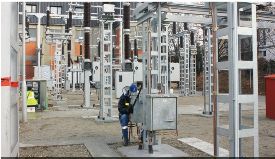
Вождовац ће имати добро снабдевање: ТС „Београд 13“
