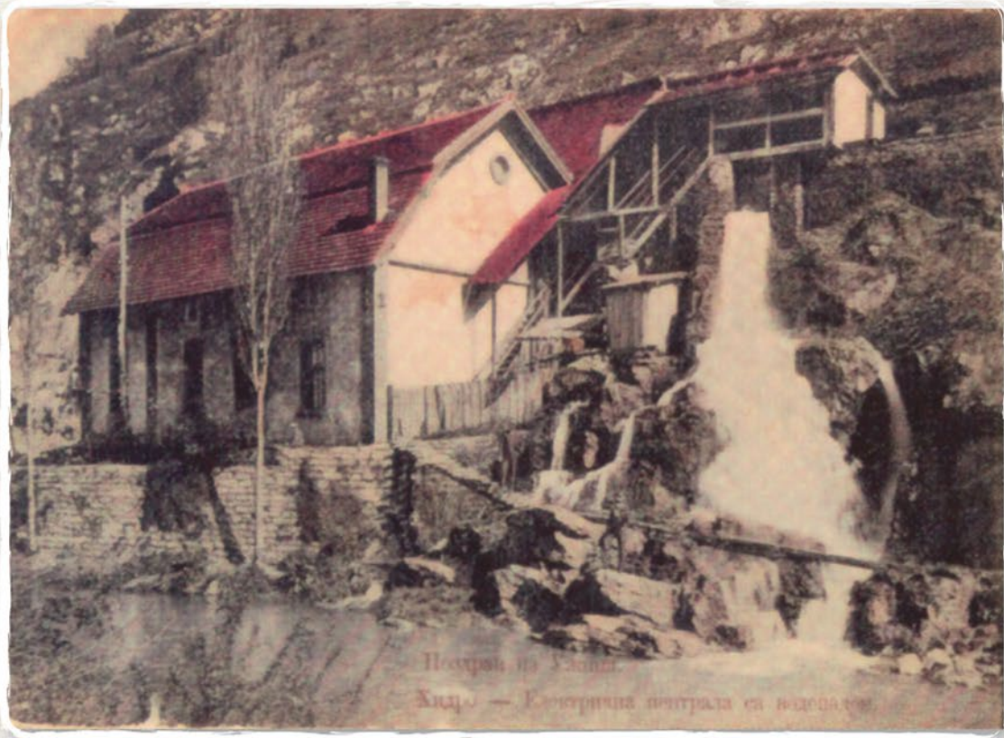
Хидроелектрана „Под градом“ у Ужицу (1900) прва је електрана у Србији која је радила по Теслиним принципима полифазних струја
