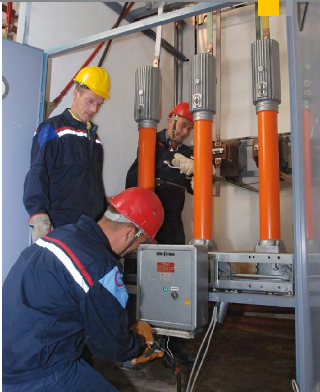
У току ремонти на електроенергетским објектима : ТС 35/10 kV Прибој
