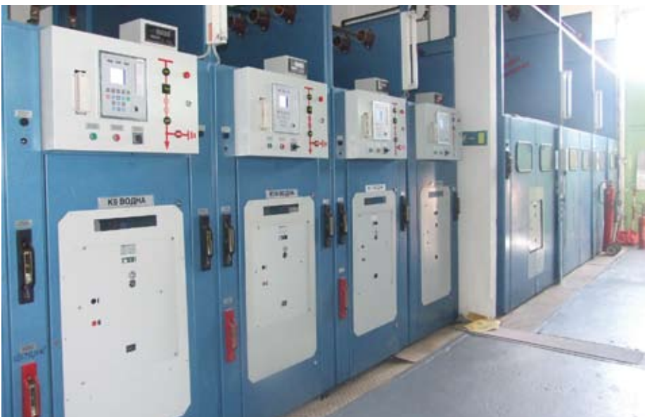
Реконструкција ТС „Смедерево 12 – Лугавчина“ обављена у две етапе
