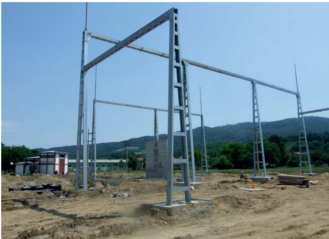
У Нересници подигнути носачи за опрему ТС 110 kV из средстава Светске банке
