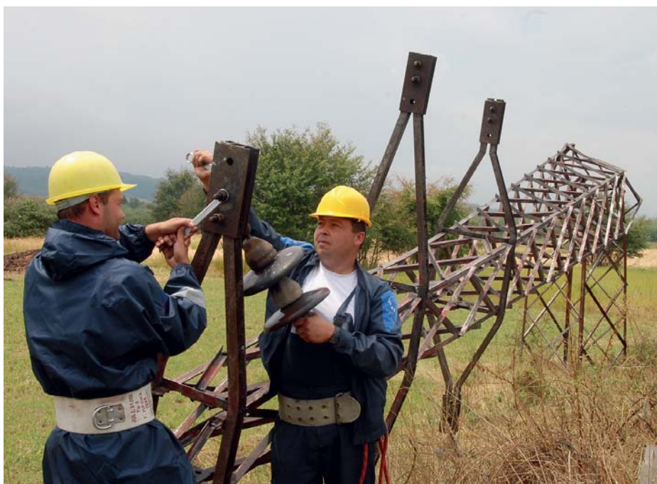
Санирање последица рушења далеководног 35 kV стуба
