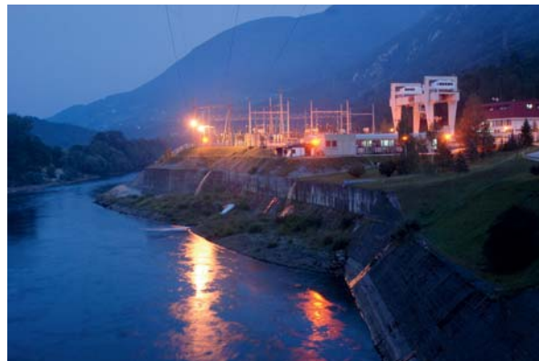
Ремонт РХЕ „Бајина Башта“ ове године без обимнијих и значајнијих послова
