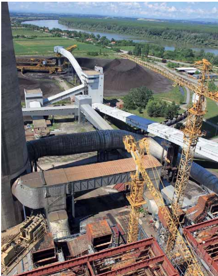
За месец дана од заустављања „двојке“ завршена демонтажа опреме која се мења
