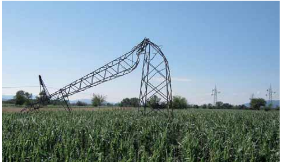
Општина Алексинац била у мраку због два срушена далековада
