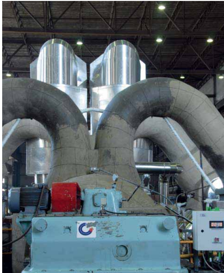
У ТЕ „Костолац Б-2“ урађен комплетан ремонт турбоагрегата, са елементима реконструкције
