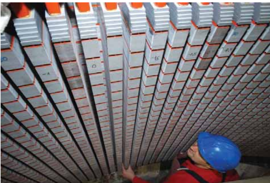
На реду радови на сређивању статора
