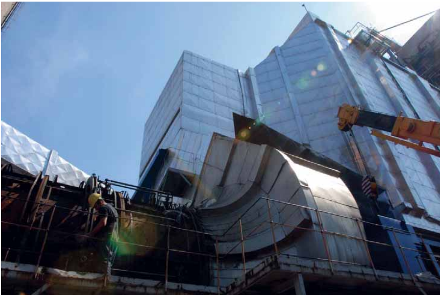
Реконструкција електрофилтерских постројења у ЕПС-у завршиће се 2013. године: електрофилтери ТЕ „Костолац А“
