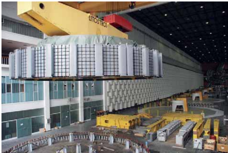
Радови на монтажи ротора главног генератора
