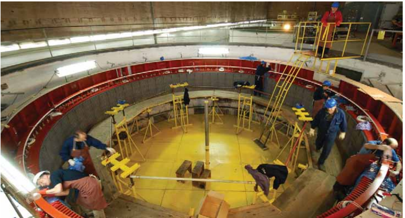
Пуно посла у машинској хали електране
