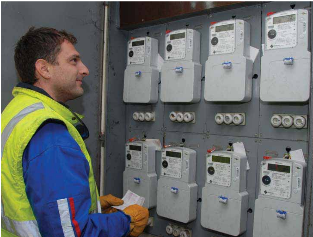
Уградњом савремених бројила смањује се могућност за крађу електричне енергије: из „Електродистрибуције Београд“
