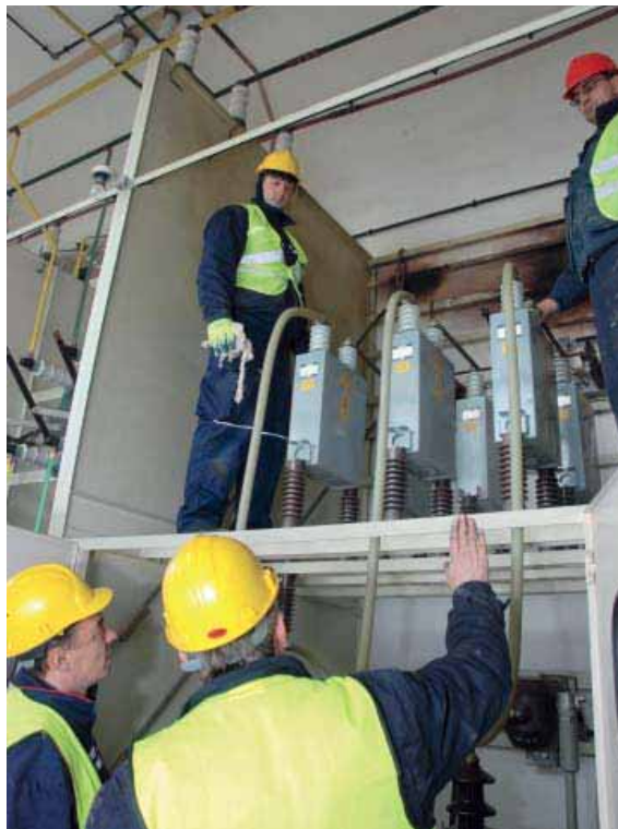
Замена растављача у ТС 35/10 у Смедеревској Паланци
