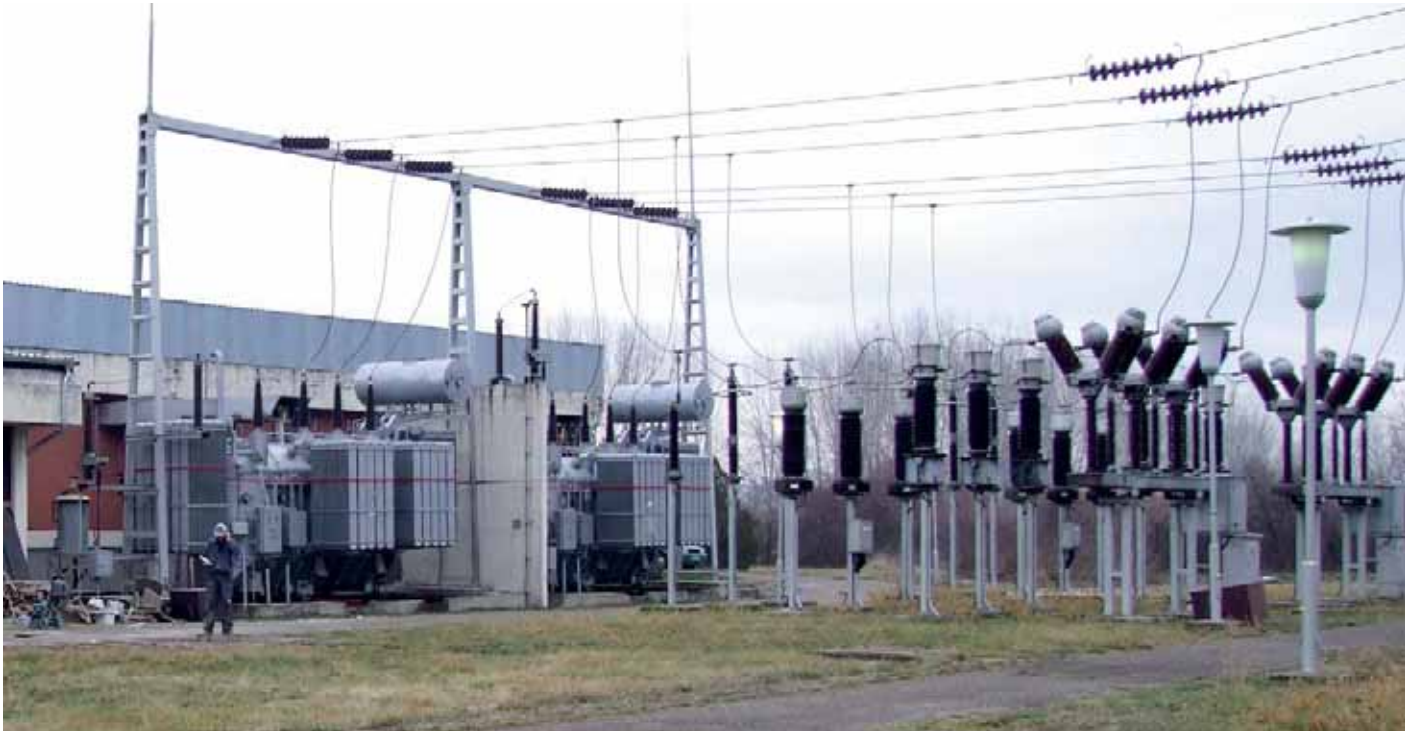
ТС „Београд 22 – Барич“ уклопљена у 10 kV мрежу ЕДБ
