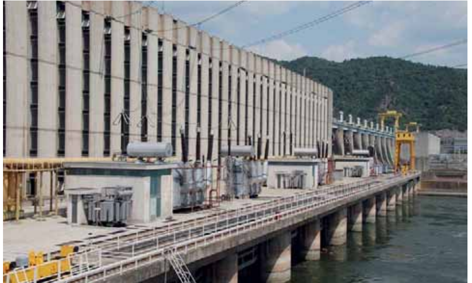
Проточне хидроелектране у јануару произвеле више од милијарду kWh: ХЕ „Бердап 1“
