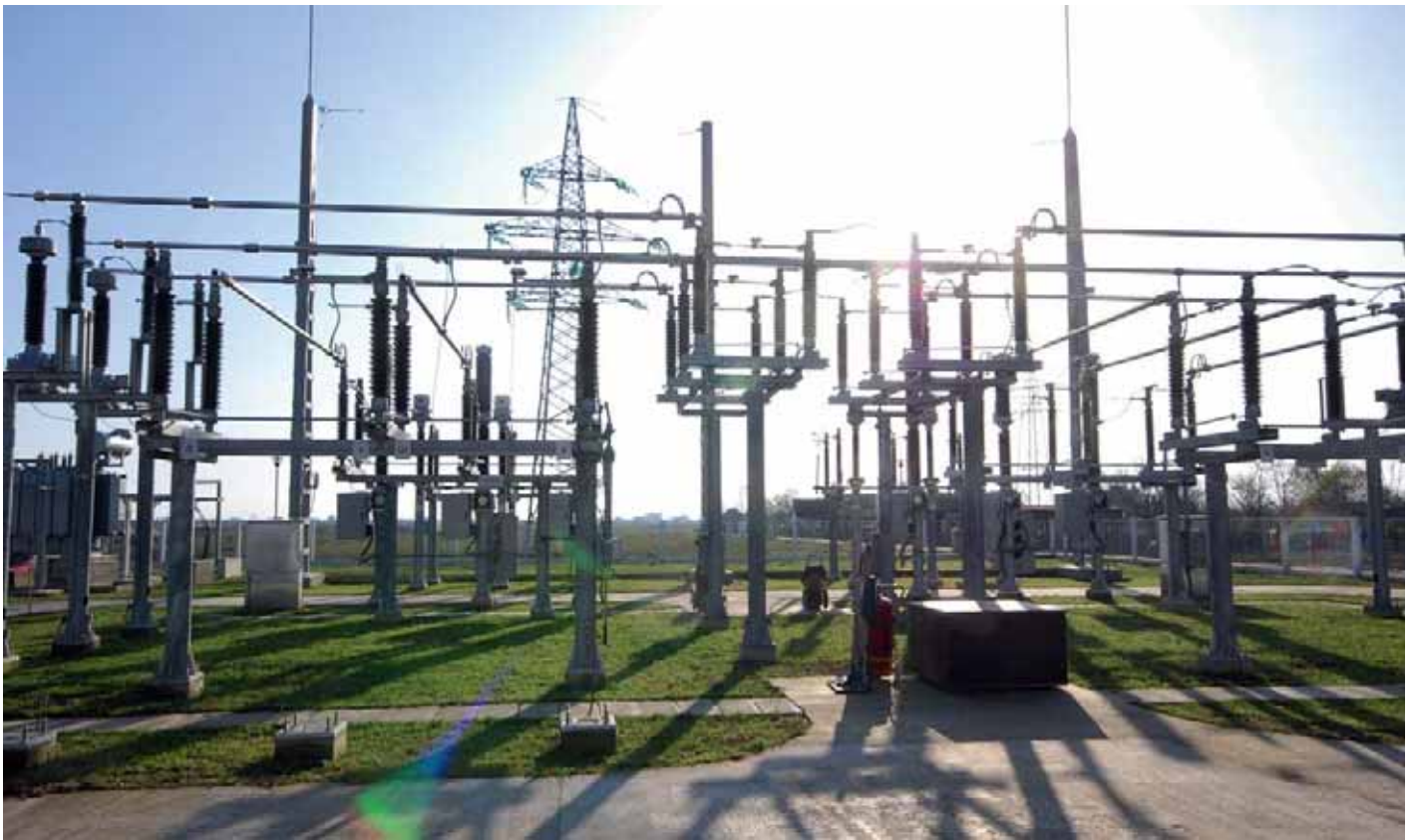
Светска банка фокусирана и на замену и надоградњу трафо-станица
